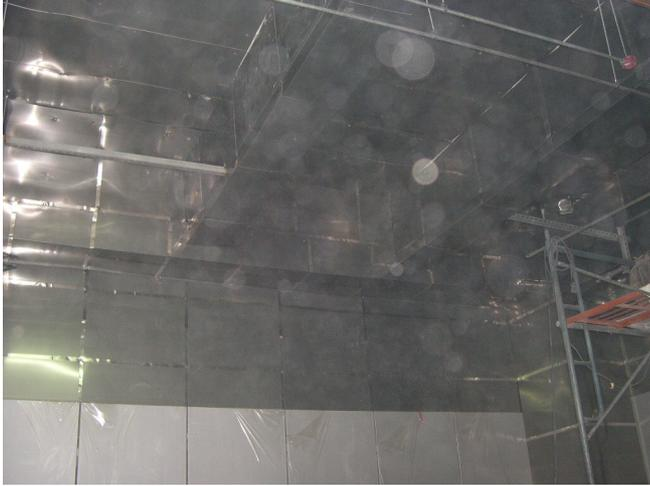
牆面、頂板防磁合金施工中
